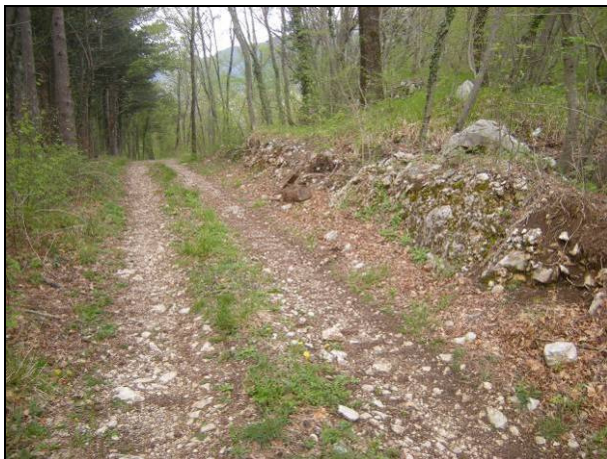
Potek trase po kolovozu, po položnem delu terena, ki se blago spušča proti severozahodu. Teren gradijo pobočni grušči (zaglinjeni) in breče.
