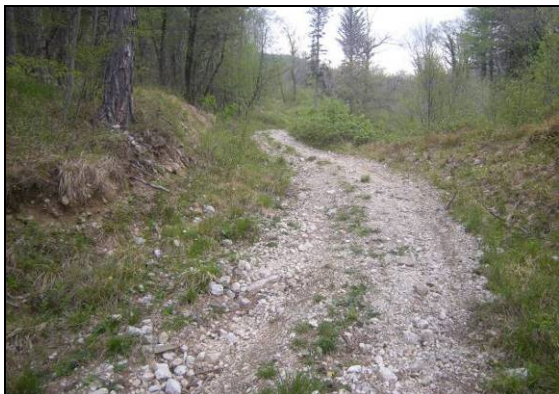
Prehod trase na pogojno stabilno do labilno pobočje, ki ga pokriva deluvij – flišna preperina (glina in zaglinjen grušč) pomešana s pobočnim gruščem.
