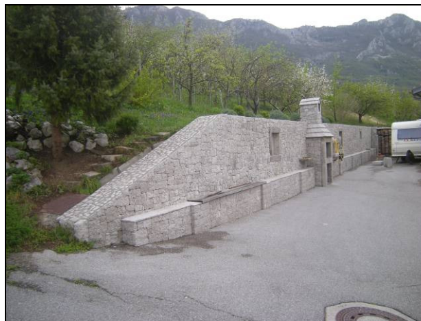
Pilotna stena nadz zadnjimi hišami v zaselku Slokarji, stabilizacija plazovitega dela pobočja.
