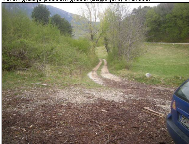
Potek trase po kolovozu, po položnem delu terena. Teren gradijo pobočni grušči (zaglinjeni) in breče.
